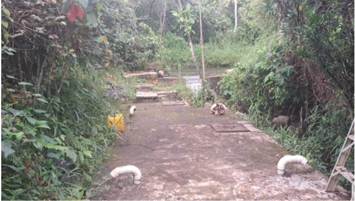
Imagen 4. Tanque de desarenador
