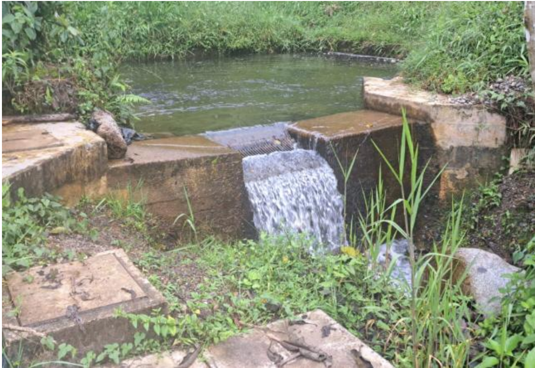
Imagen 3. Obra de captación
